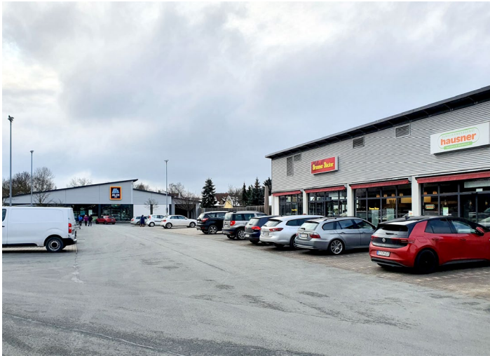
Nahversorgungszentrum in Bayreuth, Oberfranken, Bayern (Quellenhinweis – Foto: GRR Group)
